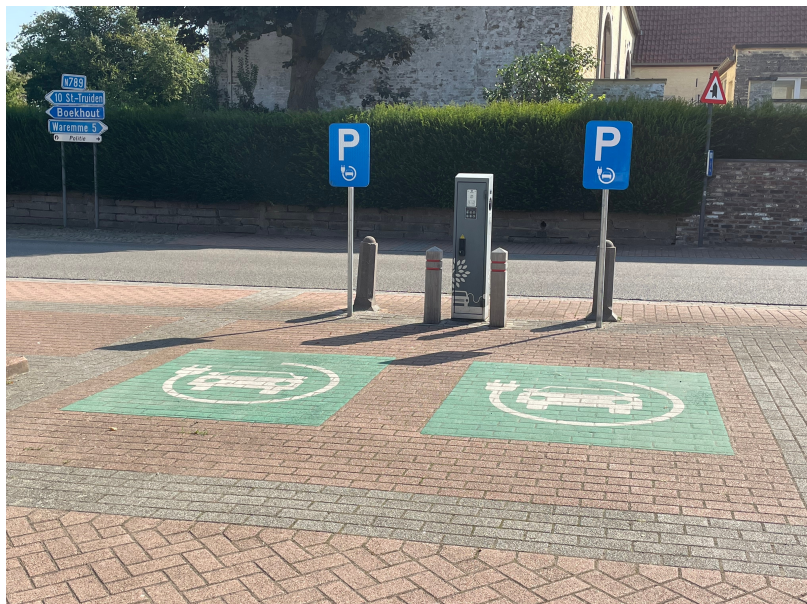
Laadpaal Willy Vannitsenplein
